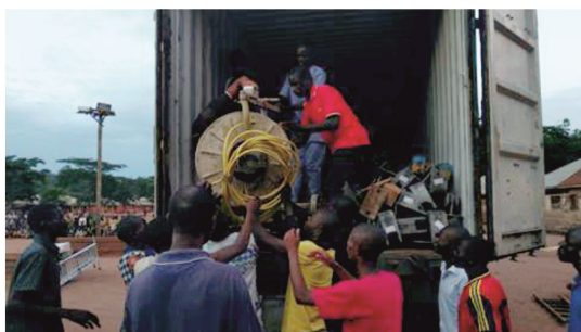
Betonmischmaschine wird aus dem Container entladen
